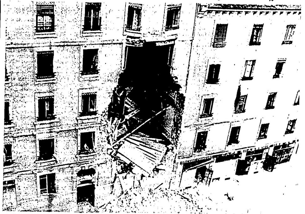
Ein Todesopfer und elf Verletzte forderte ein Hauseinsturz in Genf, der auf eine Explosion zurückzuführen ist. Die Ursache des Unglücks ist noch nicht abgeklärt.
