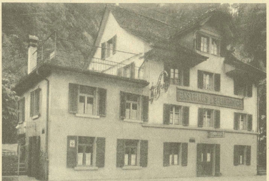
Im Gasthaus zum Steinbruch kehrten sie ein, auf dem Wandbild des Nachfolgebau wurden sie verewigt: Die Steinhauer der Baselstrasse. Das Fresko ist nach wie vor einen Ausflug wert.
