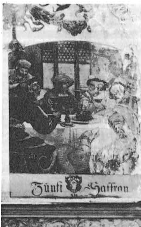
Bestandesaufnahme: Wasser hat das Bindemittel des Verputzes ausgewaschen, so dass dieser zerbröckelt.
