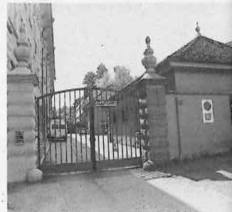
...auch die kleinen Gebäude im Anlieferungshof beim Hauptgebäude (rechts im Bild) sollen durch ein einziges Haus ersetzt werden.
