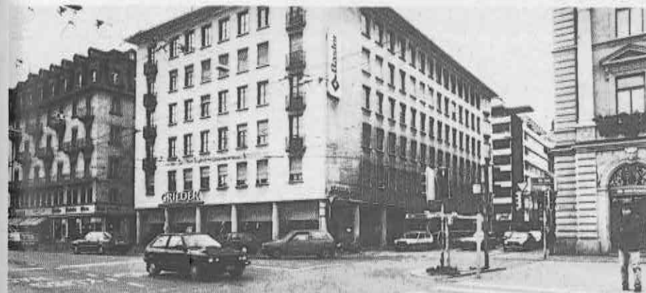
Warten auf die direkte Fussgängerverbindung vom "Grieder" zum See: Der Entscheid für den Fussgängerstreifen kann erst gefällt werden, wenn klar ist, was mit der Seebrücke und dem Schweizerhofquai passiert.
