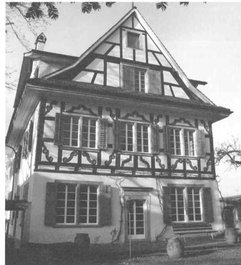
Der Landsitz von Jost Lorentius Pfyffer 1675 erbaut, ist das «Stammhaus» auf Bramberg. Foto: Hanns Fuchs
