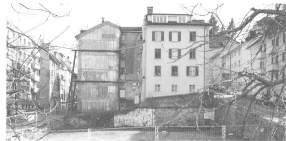
Illegal überwintert: Die «Wagenburg» auf dem Amberg-Areal wurde ohne Baubewilligung errichtet. Foto Hanns Fuchs
