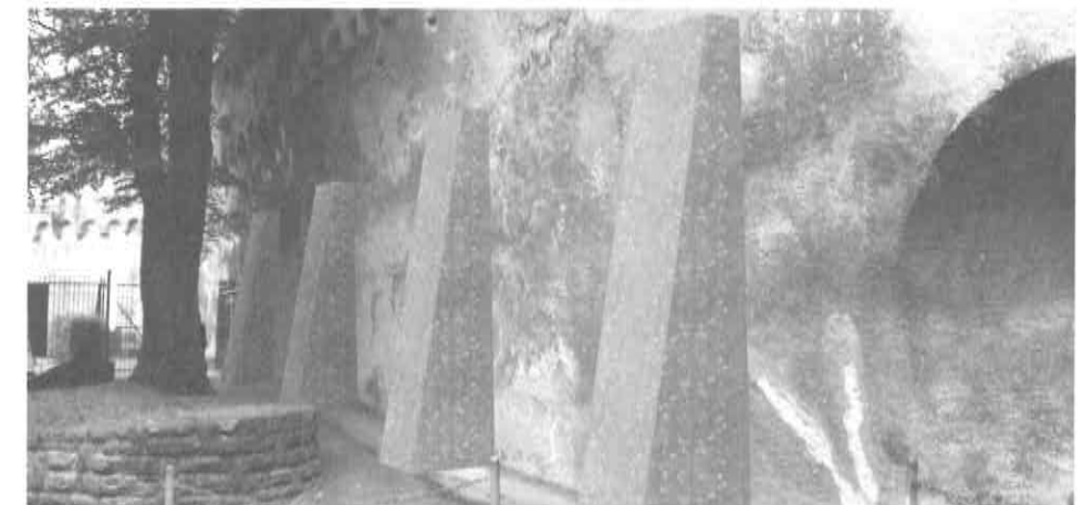
Auch eine optische Stütze: So soll die Museggmauer beim Durchbruch an der Museggstrasse aussehen. Foto zvz
