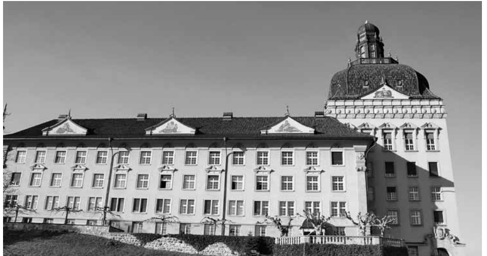
Als Mischung zwischen Kloster und Residenz werteten Architekturstudierende das Verwaltungsgebäude der SUVA auf der Fluhmatt.
