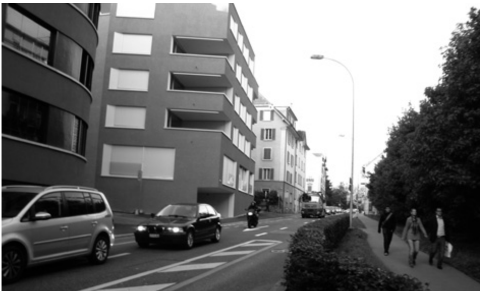
Der Neubau an der Friedentalstrasse ist fertig, Weg und Strasse sind wieder normal begeh- und befahrbar.
