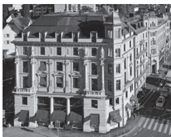
Die «Vier Jahreszeiten» stehen im 5. Stock des Genferhauses (Ecke St.-Leodegar-Strasse/Haldenstrasse).
