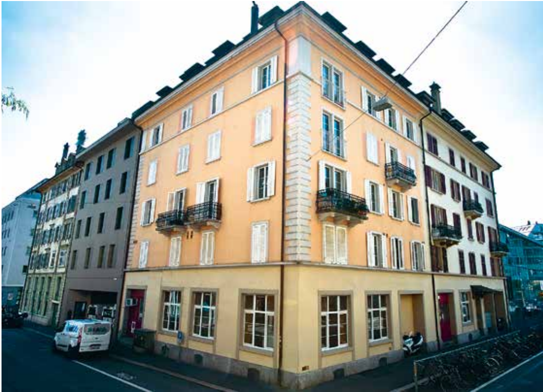
Ein Komplex, drei Adressen: An Löwenplatz, Weystrasse und – nicht im Bild – an der Friedenstrasse sind die Heini-Produktionsstätten und 40 Wohnungen untergebracht. Bild Verena Di Gallo
