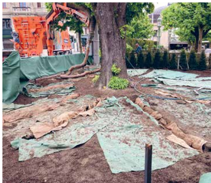
Erste Rettungsmassnahme: Durch die in Luzern erstmals eingesetzte Technik «Radical Trenching» sollen sich neue Wurzeln bilden.
