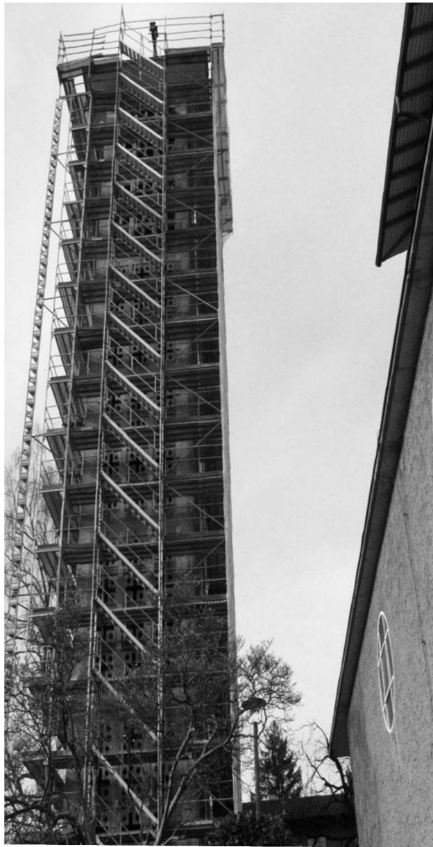
Turmgerüst am Maihofkirchturm
