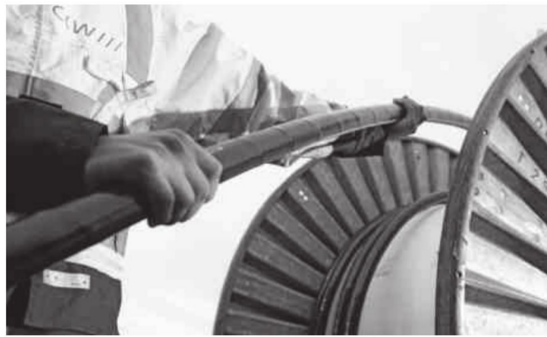
Abrollen des Stromkabels
