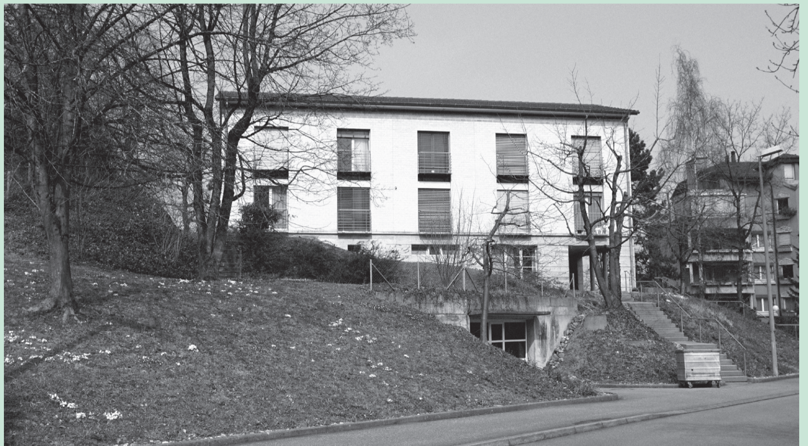
Das Wohnhaus 2 befindet sich im Rosenberg-Quartier in Luzern und bietet Platz für zehn Bewohnerinnen und Bewohner. Bild: GaZ
