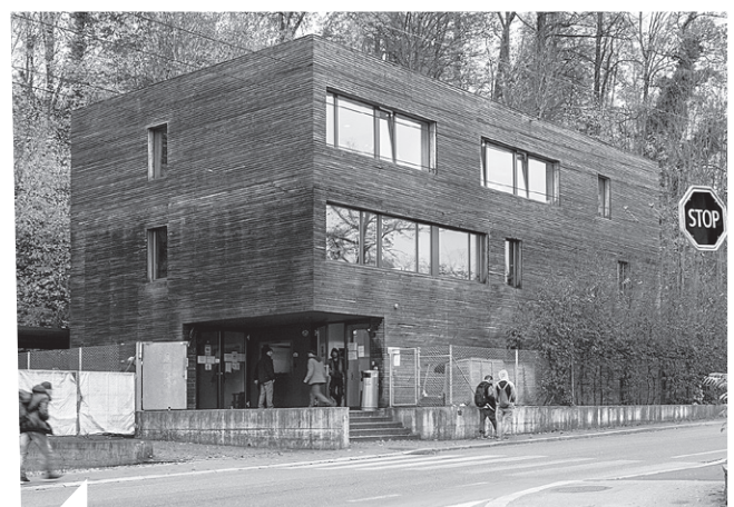
GasseChuchi - K+A - Die aktuelle GasseChuchi mit integrierten Konsumationsräumen im obersten Stockwerk. Foto Jutta Vogel
