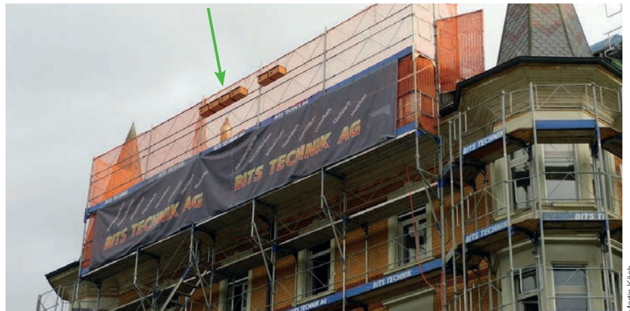
Mauersegler nehmen auch Nistkästen an, die am Baugerüst angebracht sind, wenn die bestehenden Brutplätze während einer Renovation nicht erreichbar sind.
