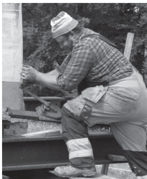
Krafteinsatz: Mit der Hebewinde wurde die 17 Tonnen schwere Kapelle über Doppel-T-Eisenträger auf den Tieflader geschoben.
