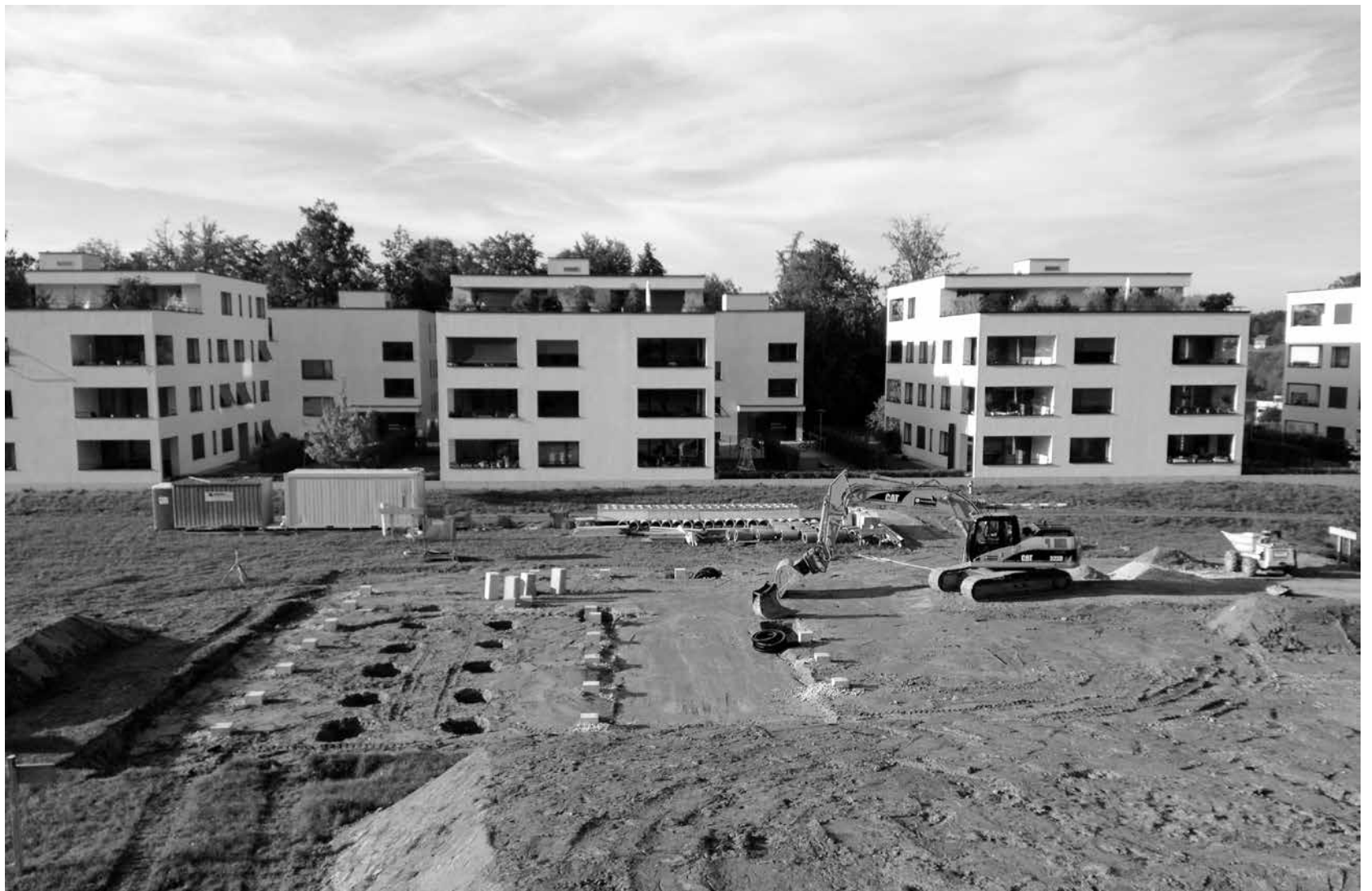
Die Aufbauarbeiten kommen gut voran (Foto: Urs Schlatter)
