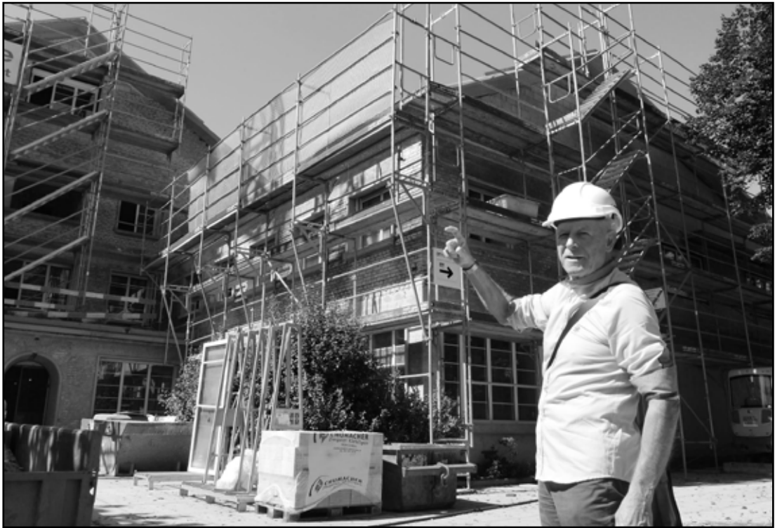
Baustelle Altersheim Unterlöchl: Geschäftsführer Hans Lustenberger erklärt die Details.
