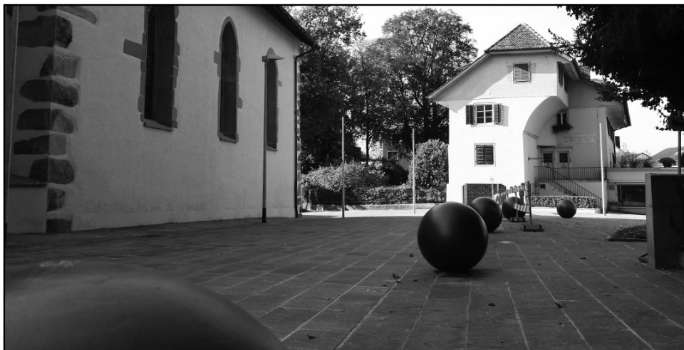
Die Steinplatten auf dem Klosterplatz wurden komplett ersetzt.
