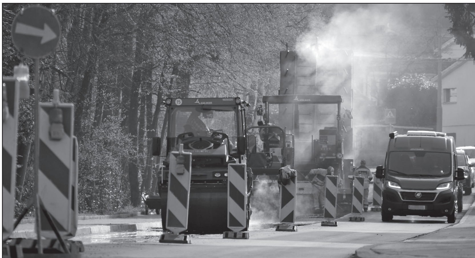
Abschlussarbeiten auf der Baustelle Hünenbergstrasse: Seit Anfang April rollt der Verkehr wieder zweispurig.
