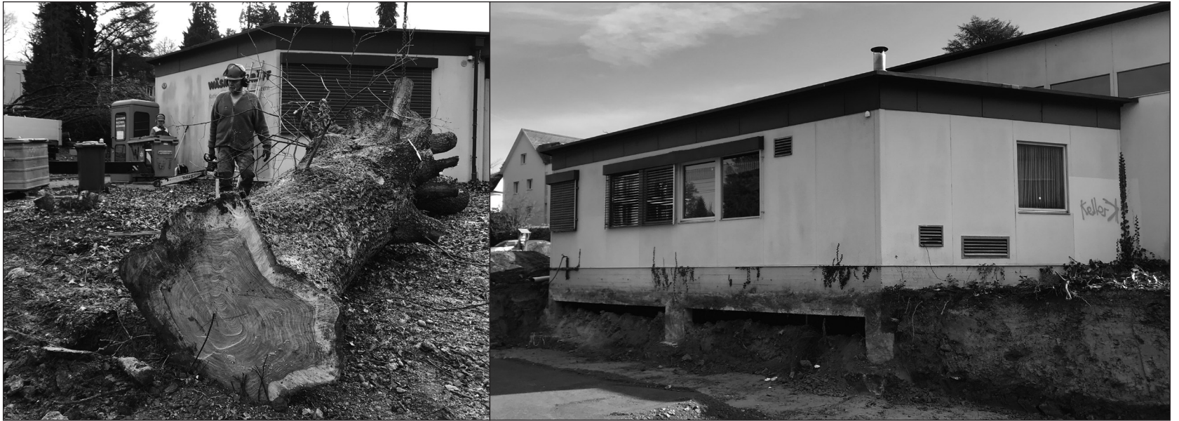
Ungewohnte Anblicke: Die Anfang März gefällte Jubiläums-Eiche und der bis aufs Fundament freigelegte alte Treff kurz vor dem Abriss.
