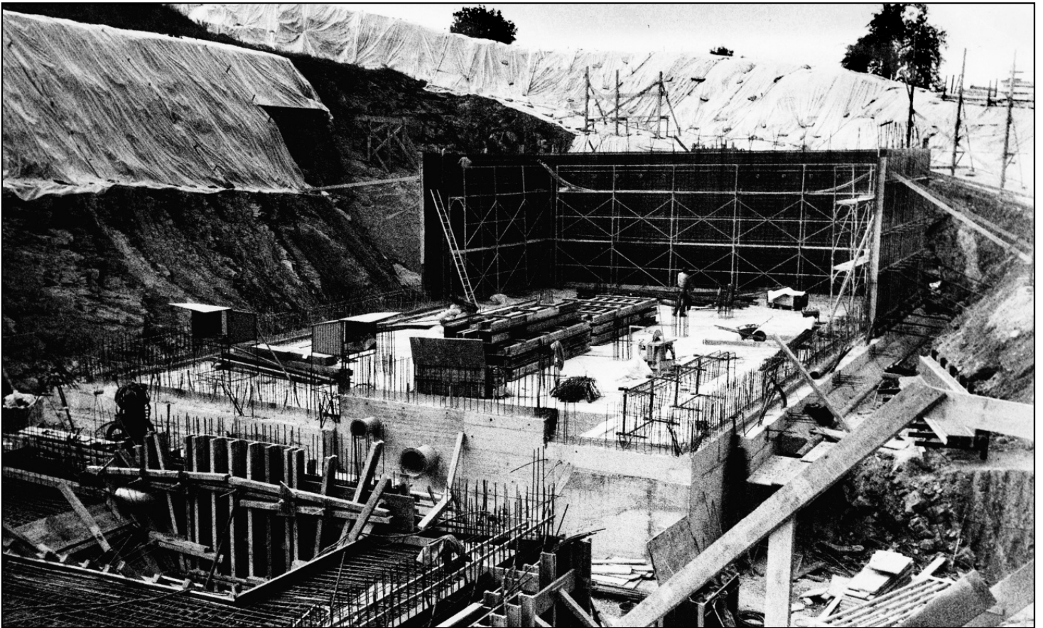
Wasserreservoir Utenberg: Eine gewaltige Baustelle war nötig, um das 1988 in Betrieb genommene Werk zu erstellen.
