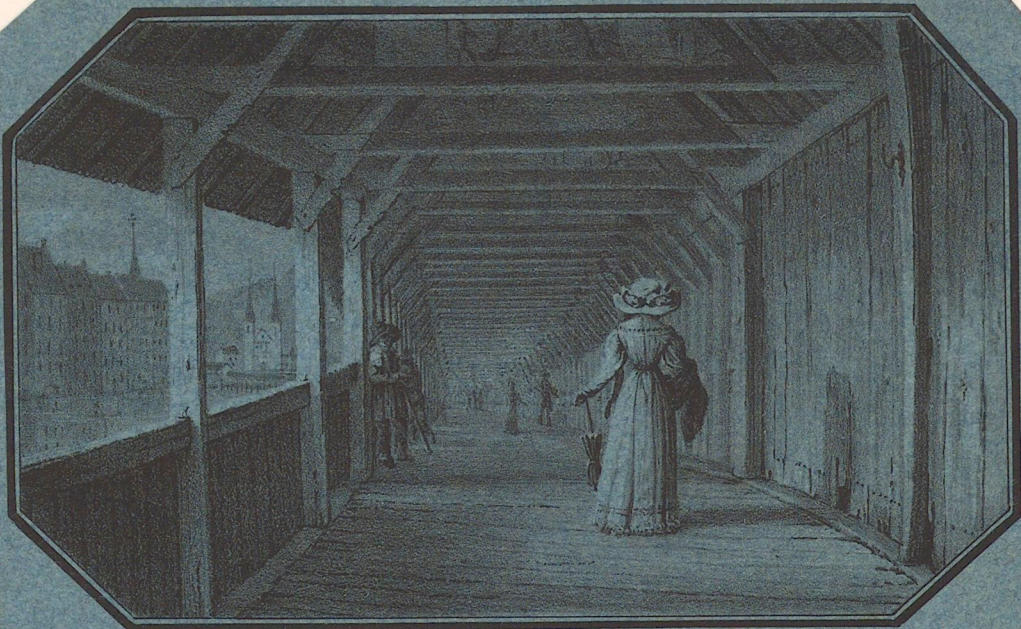
Das Innere der Kapellbrücke.
