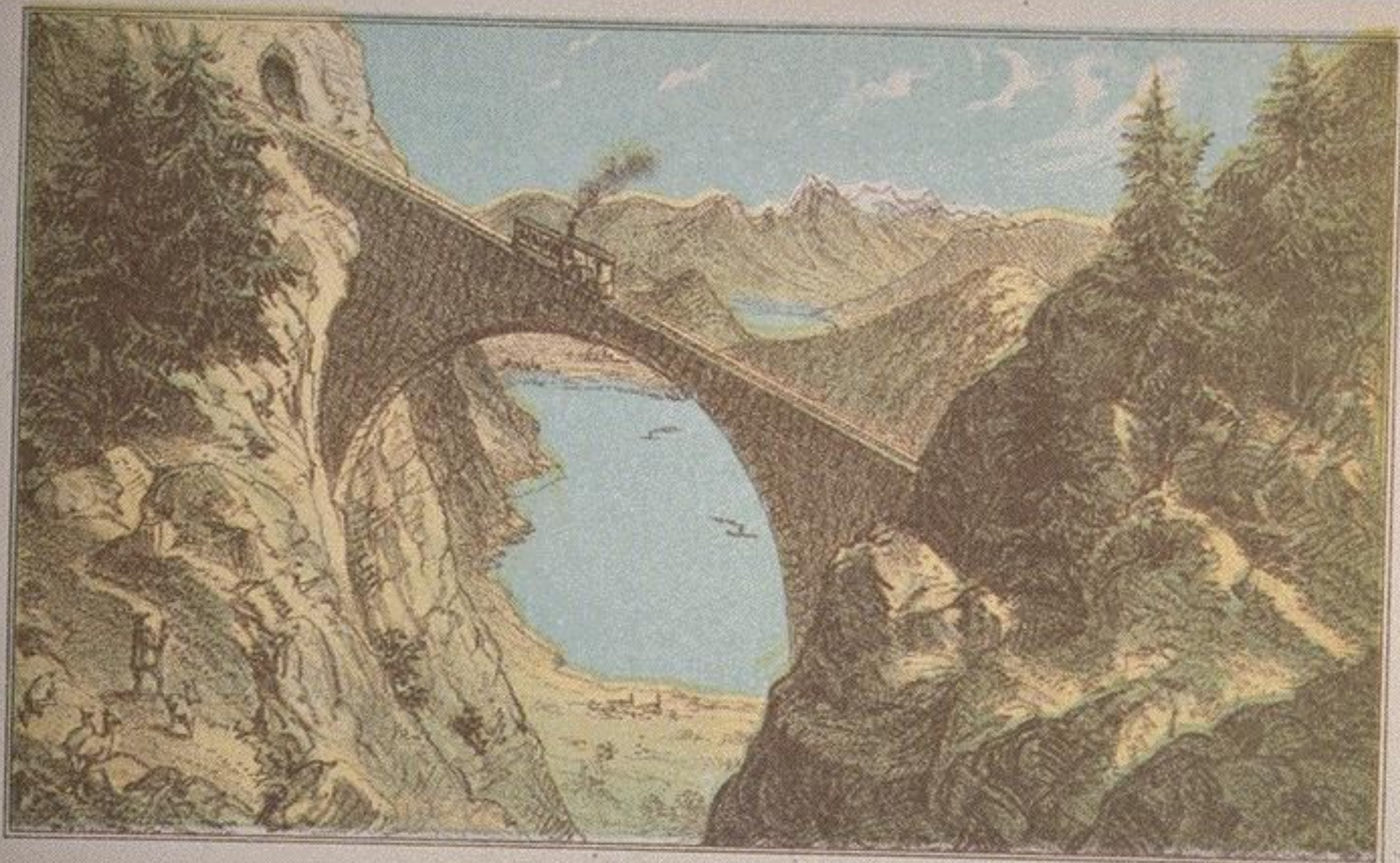
WOLFORTBACH-VIADUCT DER PILATUSBAHN.
