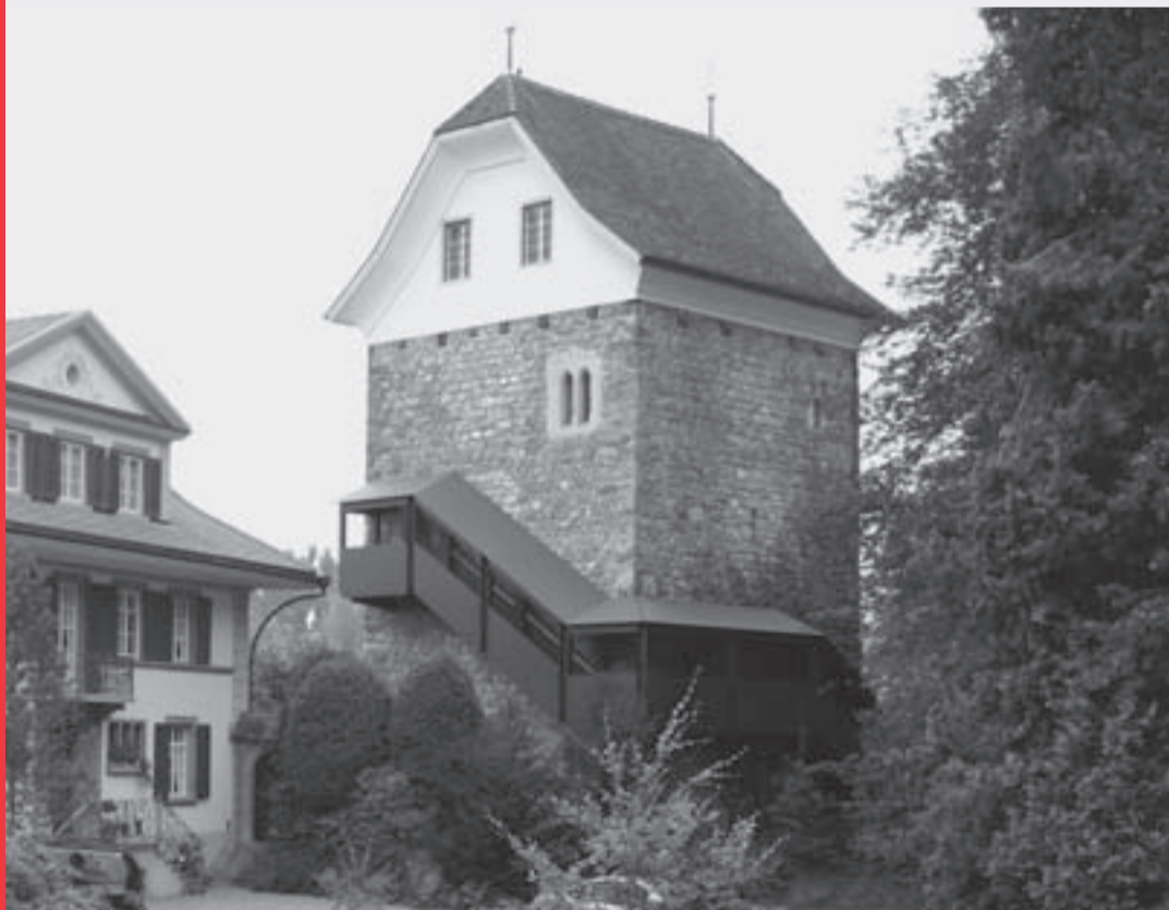
Der Hexenturm mit seiner neuen Aussentreppe. Foto Peter Omachen.
