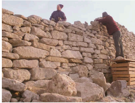
Trockenmauerbau |Pit Stöckli
