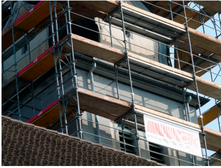
Bauarbeiten an der Pfarrkirche Eich
