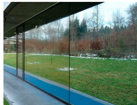
Test von neuem Glas an der Sporthalle Kotten in Sursee: 90% weniger Kollisionen |Hans Schmid
