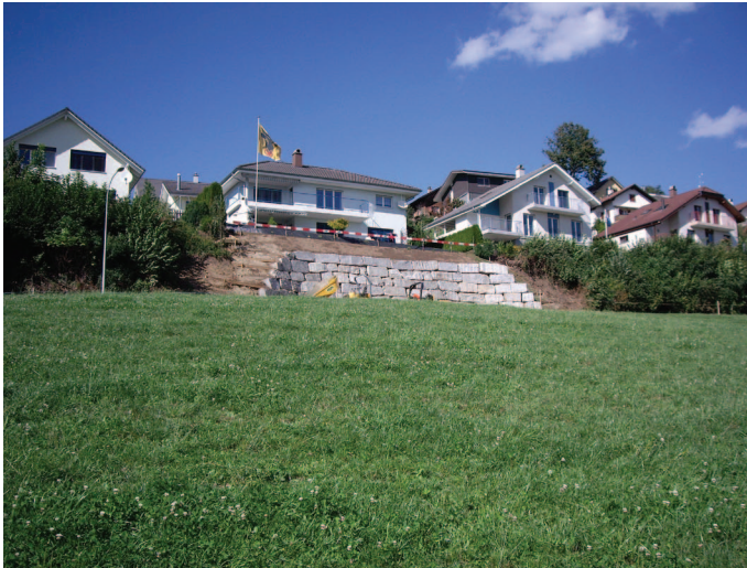
Heckenrodung für die Ausweichstelle Rigiblick in Wauwil – nicht im Sinn der Schutzverordnung.
